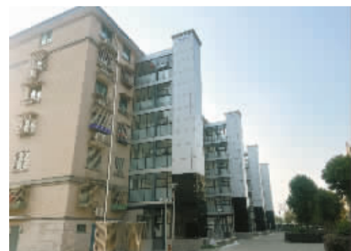
东部二村已启用的加装电梯的楼道。
