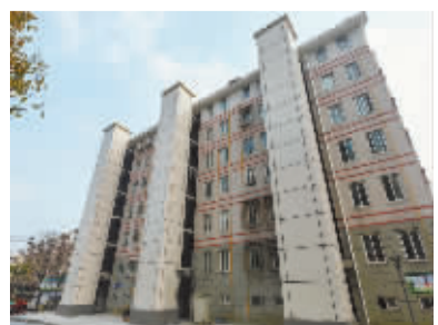
南溪家园即将启用的加装电梯。
