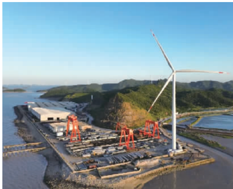
宁波能源波威重工综合智慧能源项目。
