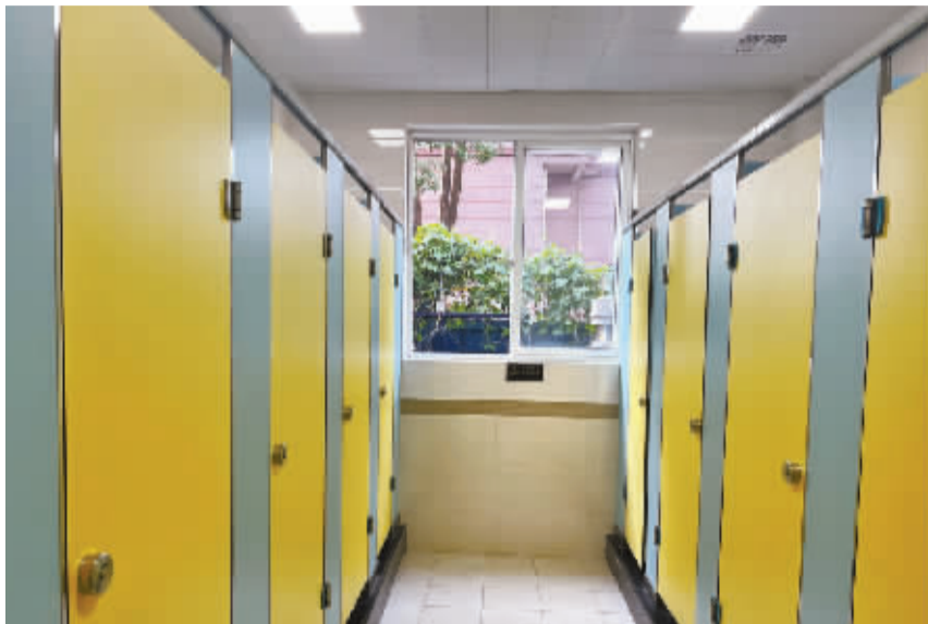
鄞州第二实验小学改造后的厕所焕然一新。
