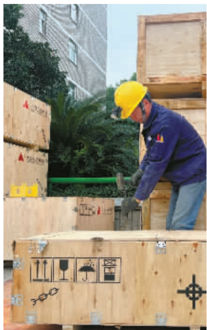
开工仪式上,施工人员进行电梯“开箱”。
