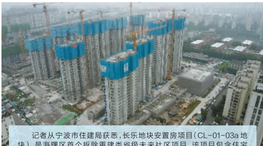
长乐地块安置房项目(CL-01-03a地块)现状。
