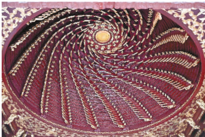
宁波府城隍庙的藻井由雕刻精细的龙凤昂层层堆叠而成。桑金伟 摄
