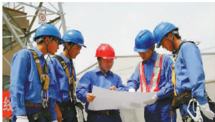
叶菴(中)在施工现场指导工作。
