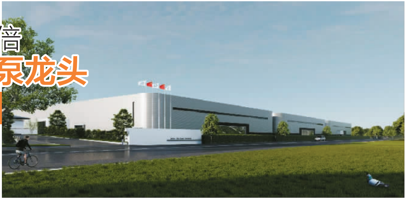
建设中的君禾股份泰国生产基地。
