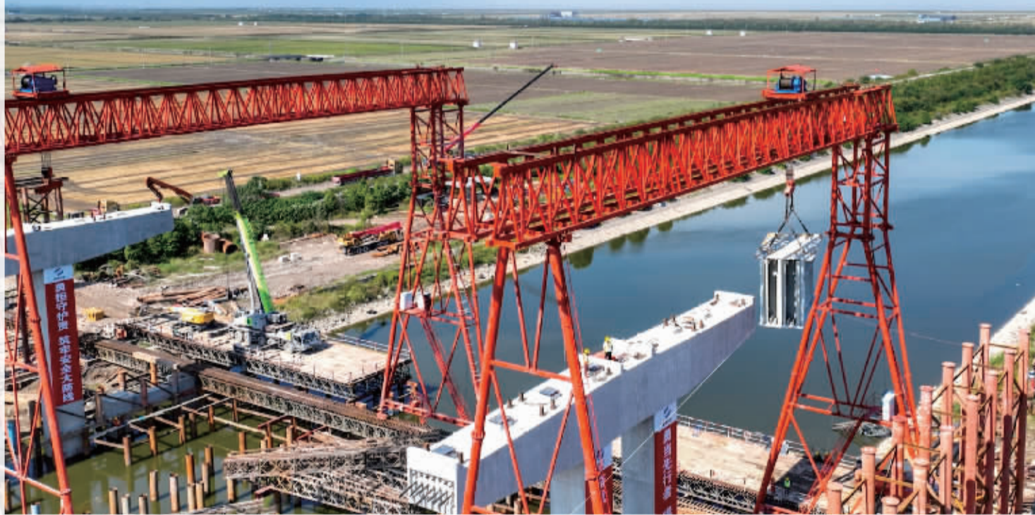
正在施工的临海大浦江特大桥。
