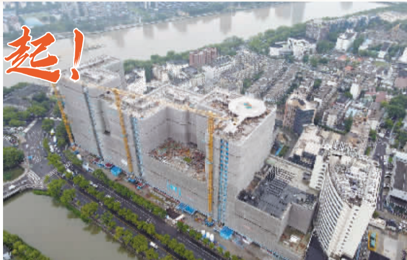
正在建设中的宁波市第二医院医疗综合大楼全貌。
