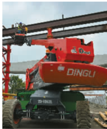
高空焊接作业。记者 周科娜 摄
