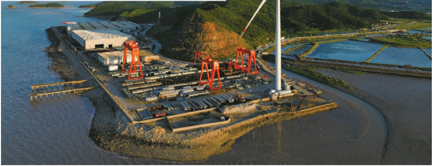
宁波能源波威重工综合智慧能源项目。
