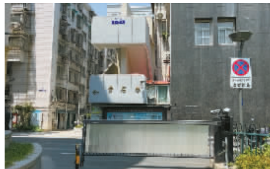
安装道闸后的青石巷。记者 周科娜 摄
