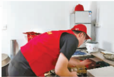
志愿者检查老人家中的燃气设施。
