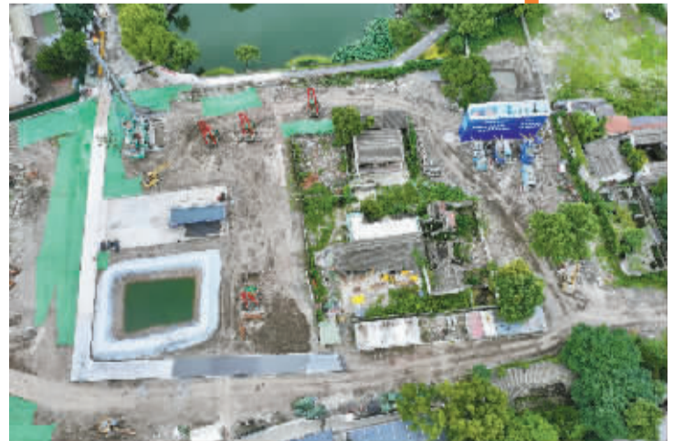
建设中的天一阁 记者 崔引 摄
