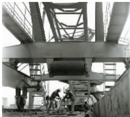
1984年，工人在安装北仑港区自动输送带。(资料图片) 李浙东 摄
