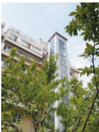
丹桂苑小区加装电梯。
