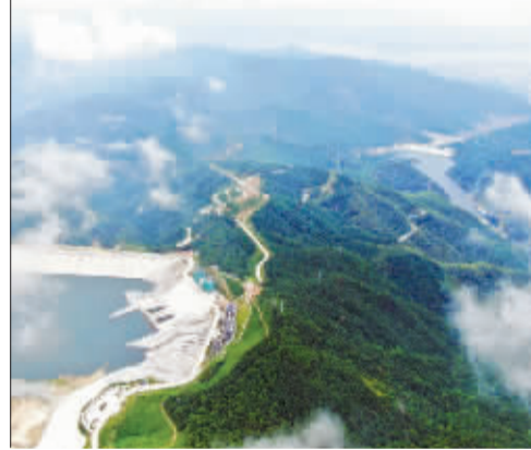
国网新源浙江宁海抽水蓄能电站上下库全景。通讯员供图
