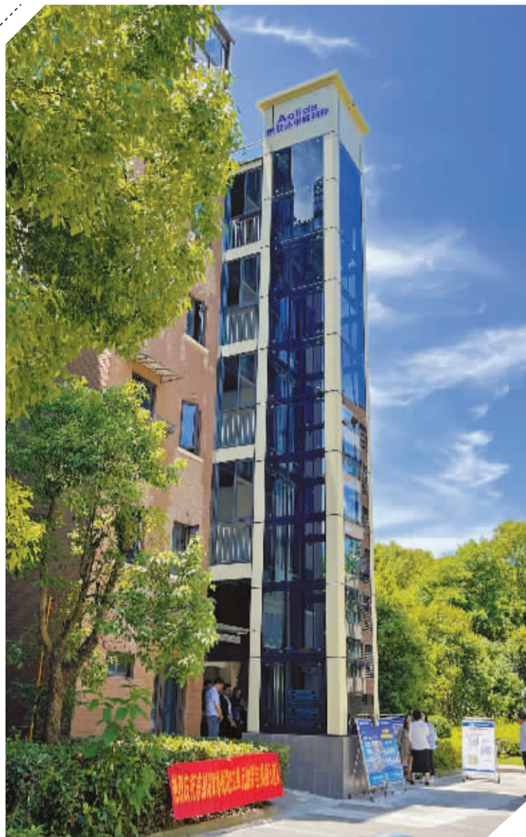
东钱湖锦绣钱湖小区的加装电梯。
