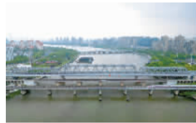
庄桥至宁波段增建三四线工程余姚江铁路桥。 范洪 摄
