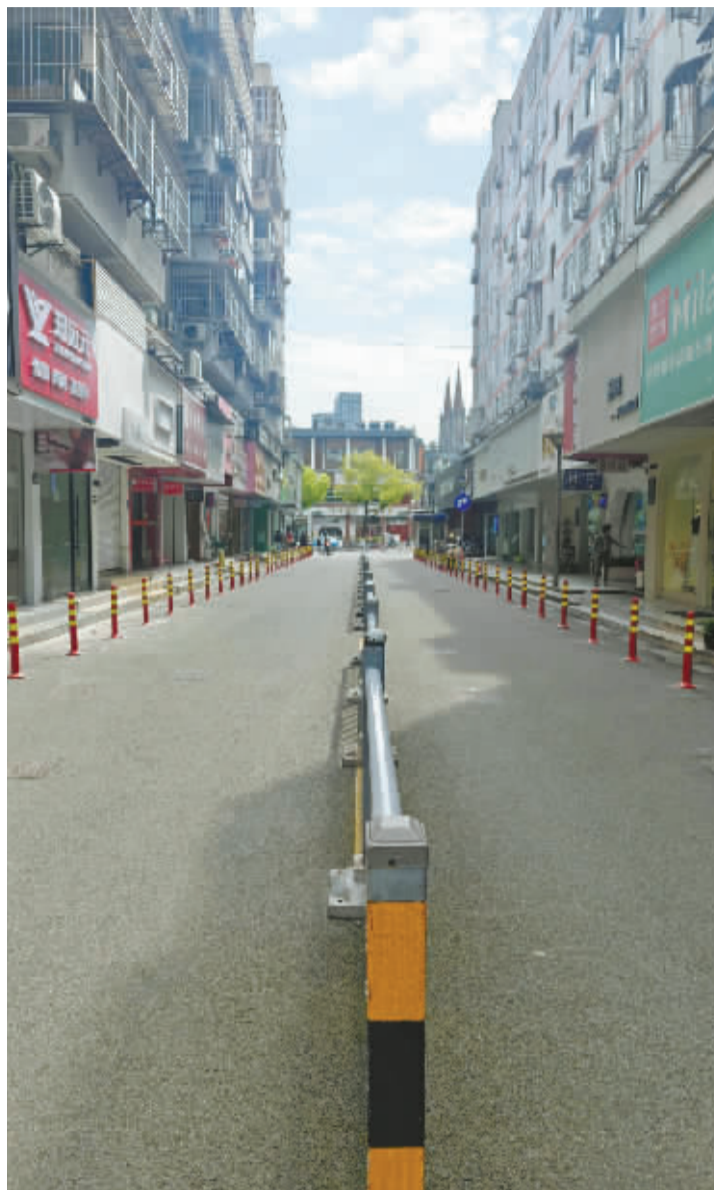
整改后,路两侧安装了隔离软桩。
