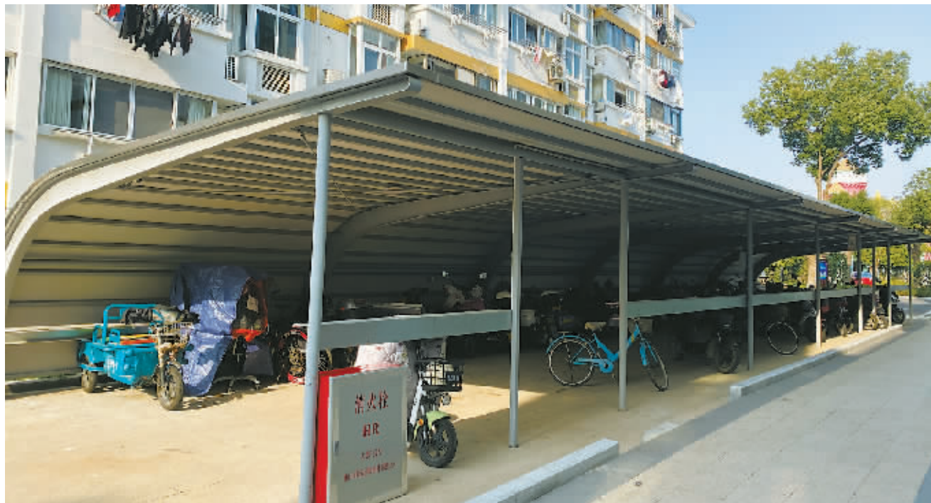
鄞州区下应街道天宫小区的电动自行车充电车棚。通讯员 姜琦 供图
