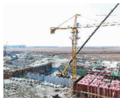
陶家路江排涝枢纽及供水工程施工现场。
