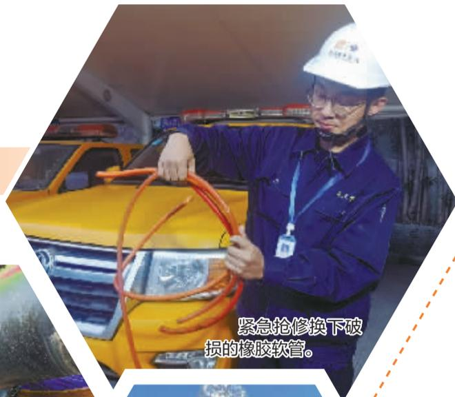
紧急抢修换下破损的橡胶软管。
