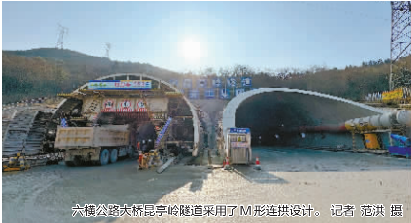
六横公路大桥高架两侧田地密布,采用“连拱隧道”设计后,使得左右2条高架路面紧紧并拢在一起。
