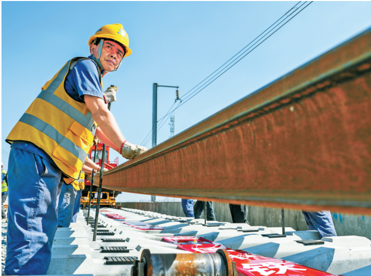
10月14日，通甬高铁全线铺轨正式启动。通甬高铁是我国“八纵八横”高铁网沿海通道的重要组成部分，建成后将进一步完善长三角地区高铁路网布局，推动长三角高质量一体化发展。图为中铁五局施工人员进行铺轨作业。（新华社记者 李博 摄）
