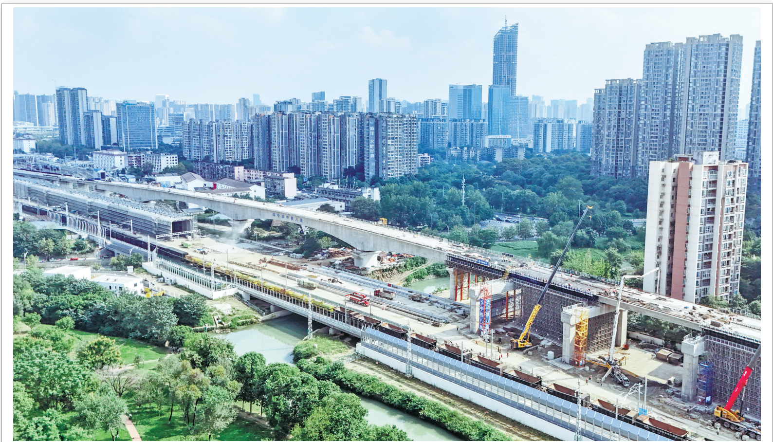
成渝中线高铁跨沙河特大桥顺利合龙 10月13日，成渝中线高铁引入成都枢纽关键控制性工程——跨沙河特大桥顺利合龙。成渝中线高铁跨沙河特大桥地处城市核心区，下穿、上跨多条既有轨道交通线路，全长约1.47公里。该桥合龙后将串联起动车往返成都站与动车所的走行路径，为成渝中线高铁后续配套工程按期完工创造条件。成渝中线高铁是我国“八纵八横”高铁网沿江通道的重要组成部分，正线全长292公里，设计时速350公里。图为10月13日拍摄的成渝中线高铁跨沙河特大桥合龙施工现场（无人机照片）。 （新华社记者 王曦 摄）
