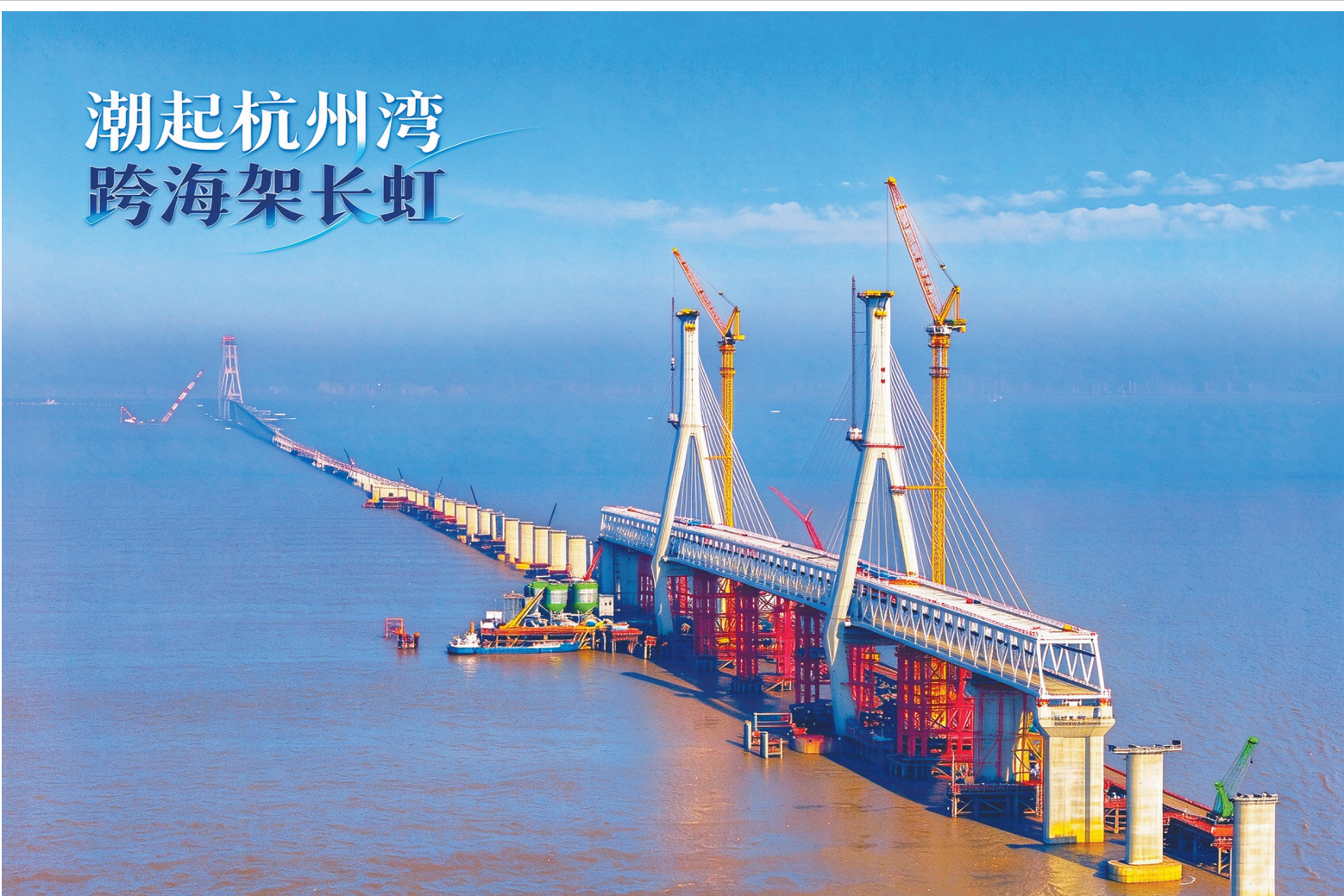
连日来，杭州湾跨海铁路大桥宁波侧海域施工稳步推进，预计本月中旬南航道桥顶推合龙。作为通苏嘉甬高铁关键控制性工程，该桥全长29.2公里，是目前在建世界最长、建设标准最高的高速铁路跨海大桥，设计时速350公里。通苏嘉甬高铁建成后，将完善长三角高铁网络，促进区域协调发展。（卓松磊 王鹏 摄）
