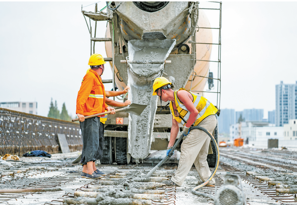
工人正在浇筑混凝土。
