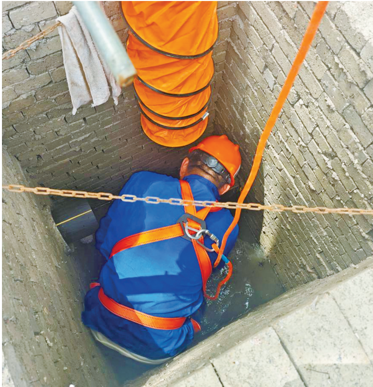
镇海区立人中学西校区燃气项目施工现场。（通讯员供图）
