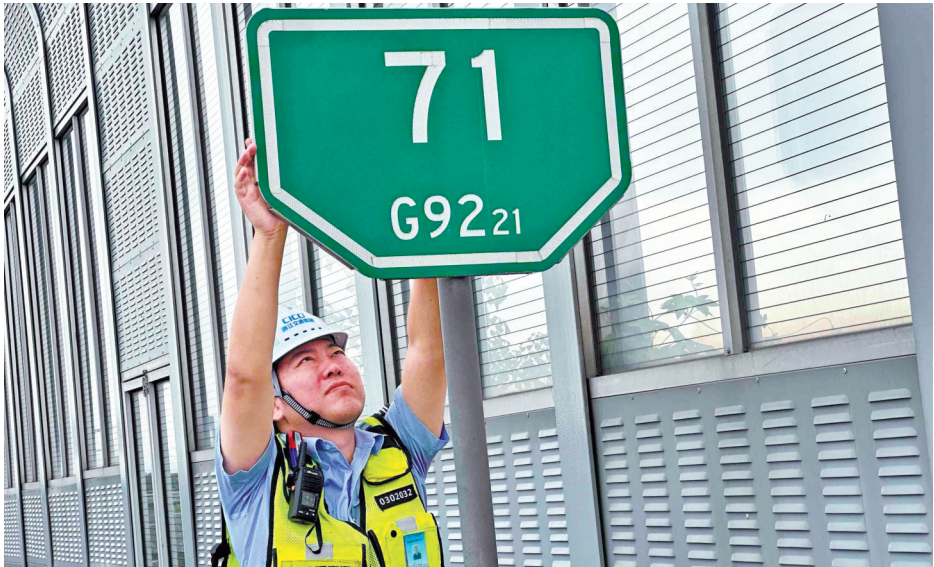
工作人员加固高速公路标识牌。(受访者供图)
