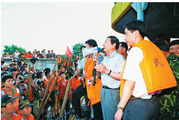
1998年8月9日,朱镕基同志在江西省九江市防洪墙堵口现场指挥抗洪抢险工作。(新华社记者 章武 摄)
