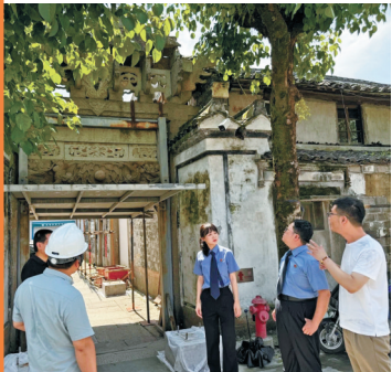
2025年3月，江北区检察院发挥公益诉讼职能，府检联动，解决当地部分古建筑风貌受损问题。
