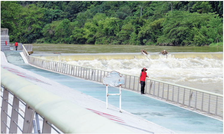
前日，在奉化区县江广渡段，防汛人员对沿线进行安全巡查，实地查看水情，排查各类隐患，守牢防汛“安全线”。（王鹏 摄）
