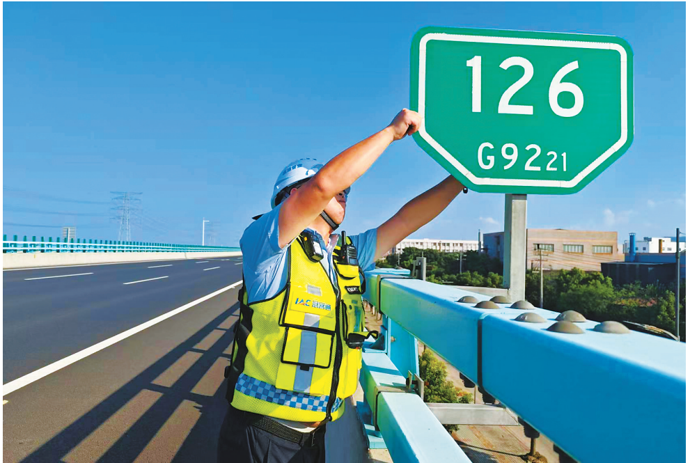
工作人员正在加固高速公路标牌。 （金鹭 余明霞 摄）
