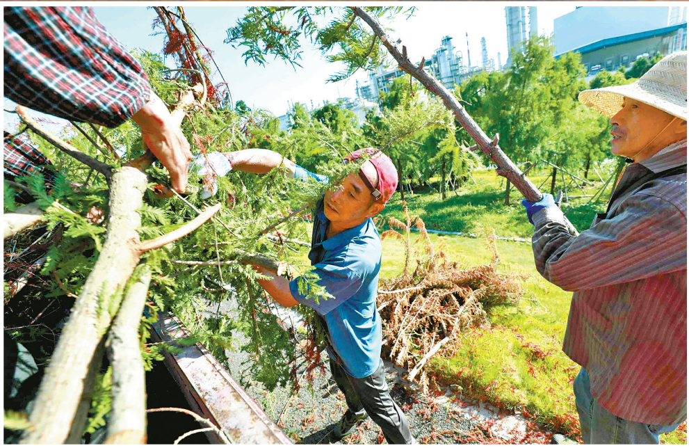
昨天，镇海区农业农村局组织巡查人员对海塘全线开展不间断巡查。图为工人正在进行树枝清理工作，以保持海塘堤顶路面畅通。 （徐诚 孙佳俊 摄）
