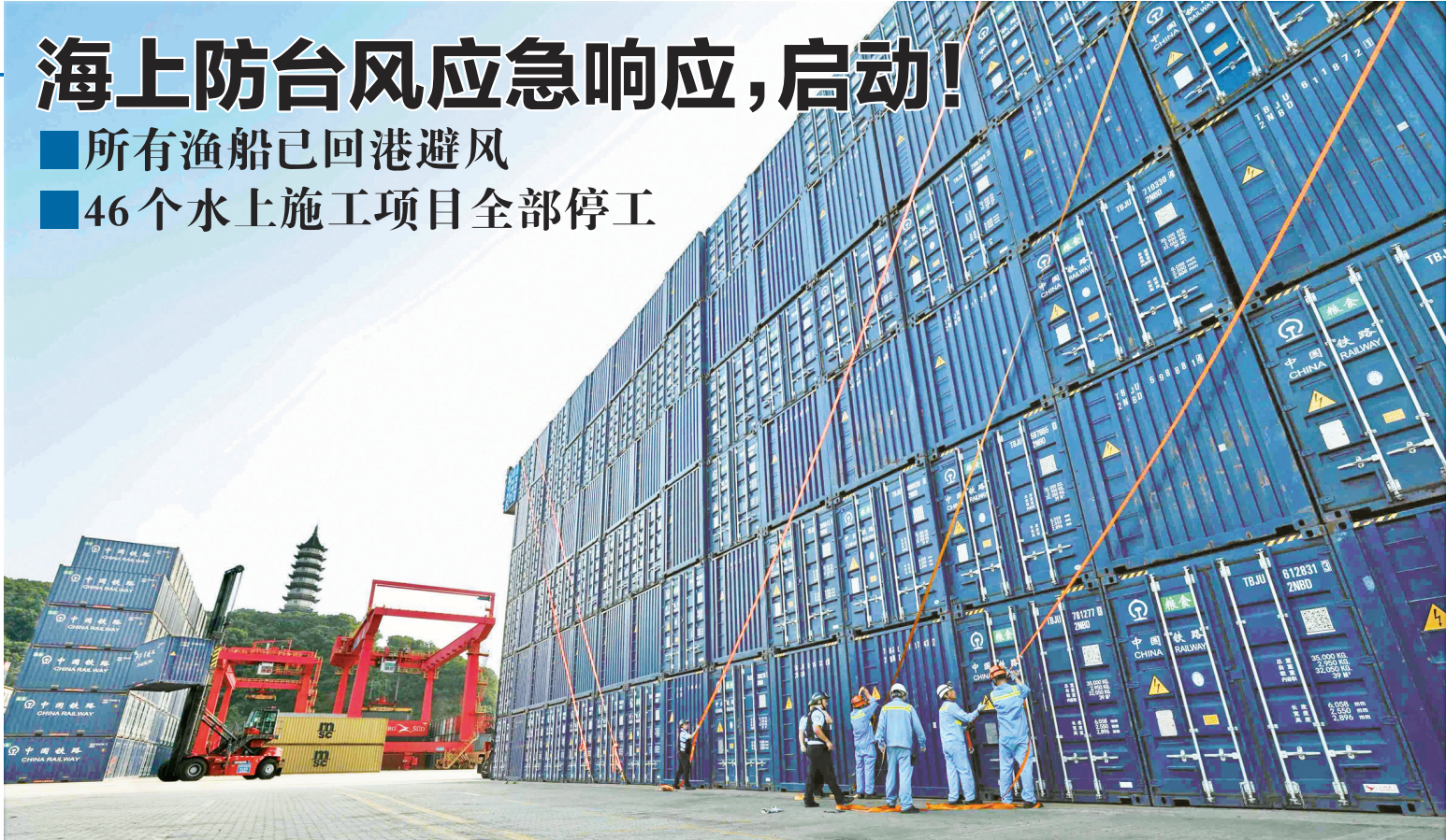
昨日，在镇海码头，宁波边检站协助码头工作人员加緊落实各项防御举措，对港区龙门吊开展防风加固，绑扎紧固露天堆放集装箱。（徐诚 陈露佳 摄）
