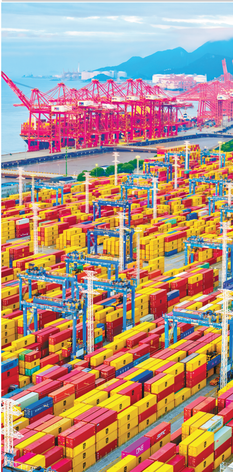
图为繁忙的宁波舟山港穿山港区。近处各色集装箱交错堆叠,形成“万顷彩箱”的壮观景象。(沈颖俊 摄)
