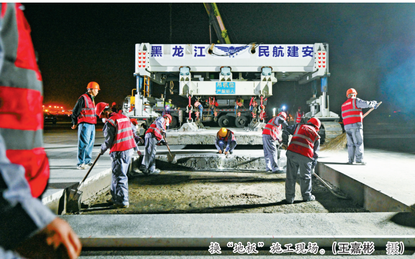
换“地板”施工现场。(王嘉彬 摄)
