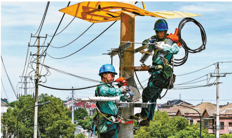
国网慈溪市供电公司工作人员在慈溪市周巷镇青龙 B815 线 15 号杆开展迎峰度夏线路优化工作。（姚科斌 摄）
