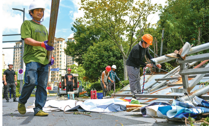
在宁波高新区江南路和创苑路交叉口，工人在拆除一块面积达100多平方米的广告牌。(王嘉彬 朱李汀 摄)
