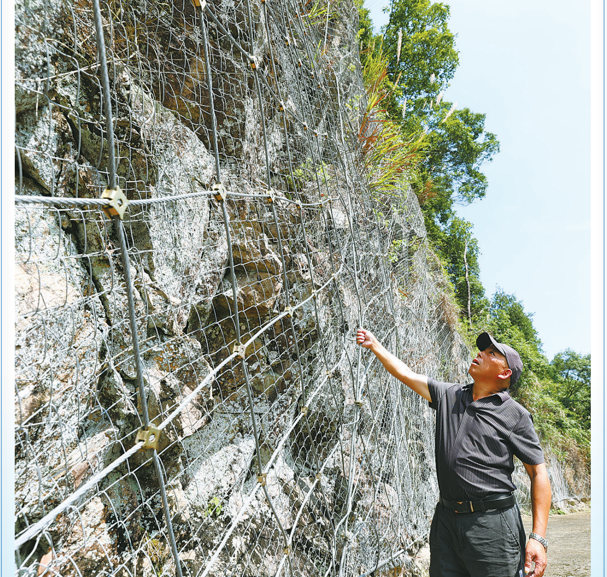
陆国安检查防止落石的钢丝绳网。（徐能 沈孙晖 摄）
