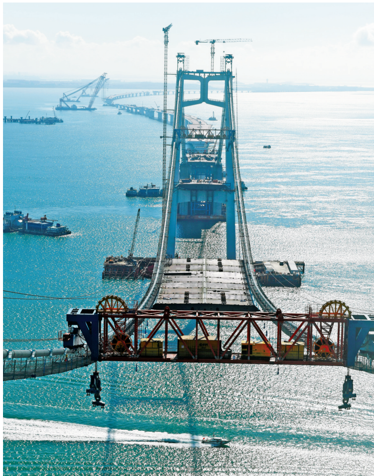
7月8日，厦金大桥（厦门段）项目观音山互通主线桥拱肋对接合龙。此次合龙攻克超大吨位钢拱肋整体提升施工难题，标志着项目取得突破性进展，为后续桥梁吊杆安装、桥面铺装等工序施工奠定坚实基础。（新华社发）
