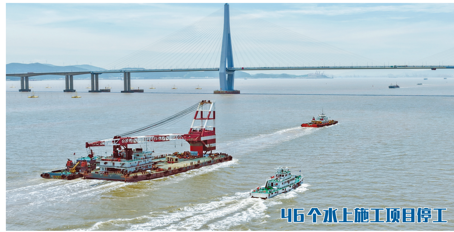
记者从宁波海事局获悉，受今年第9号台风“巴威”影响，截至昨日18时，宁波海域46个在建水上施工项目已全部停工，219艘施工船舶转移至安全水域避风。海上风电工程作业人员已于6日17时先行撤离。图为海事部门护航重点船舶撤离施工现场。（林星辰 范洪 摄）
