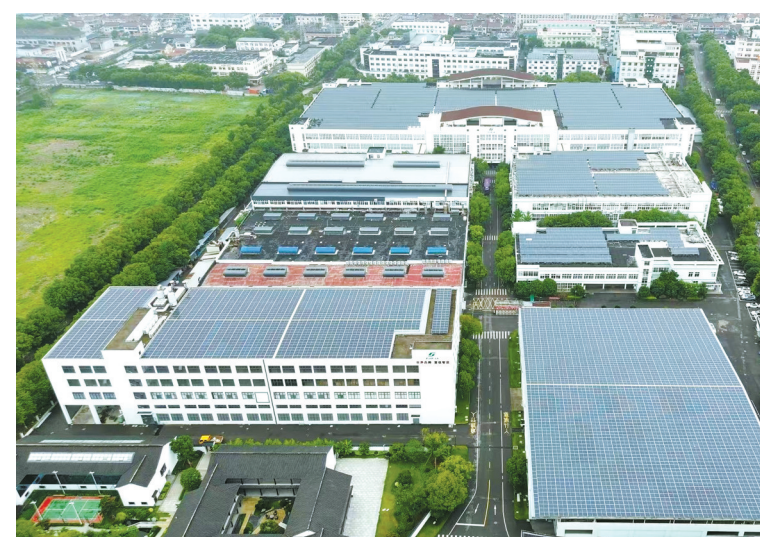
富佳实业厂房的屋顶铺上了光伏板。(顾佳诚 范榆柯 摄)
