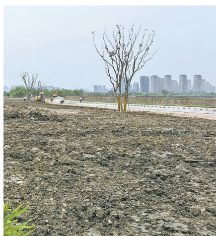
奉化江西岸，长约2.5公里滨江步道正在建设中。
