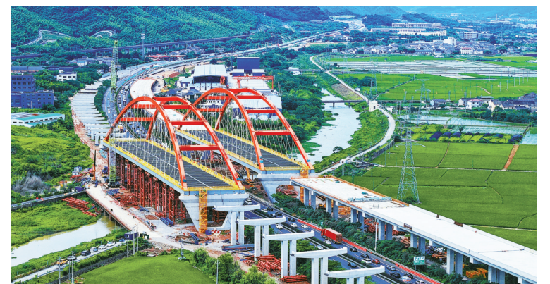
东江系杆拱桥施工现场。(陈章升 朱利娟 摄)
