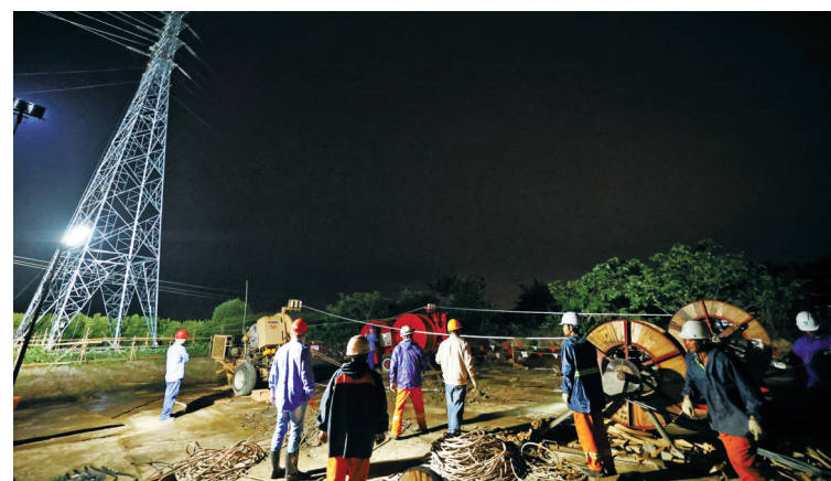
宁波送变电公司工作人员作业现场。
