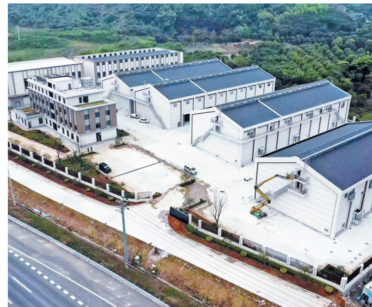
奉化区沿海粮库。
