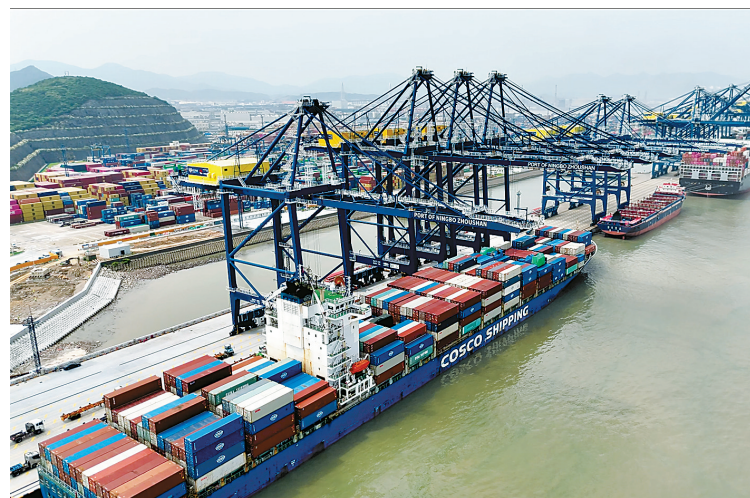
首艘外轮靠泊新建码头。
